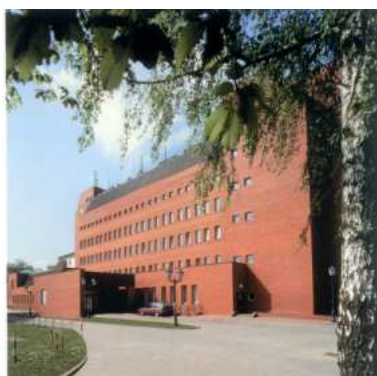
Budynek Kliniki Kardiologii w Krakowie
